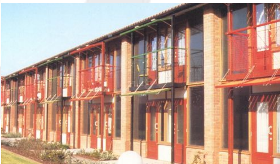
David Clarke Associates, Christopher Taylor Court a Rowheath, Birmingham, 1983-86; sistemi solari passivi a guadagno indiretto, in particolare muri Trombe-Michel.
