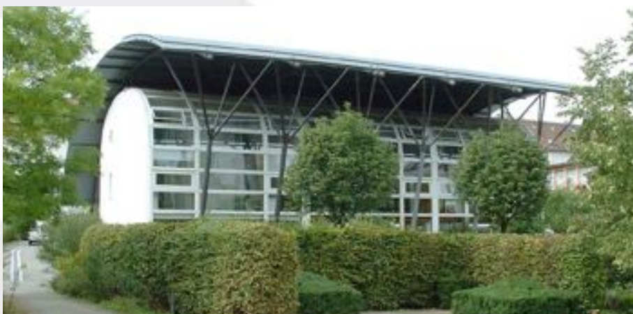
Jourda & Perraudin, Edificio dimostrativo, Quartiere dell'IGA, Stoccarda, Germania, 1993; l'edificio (composto da tre unità abitative a schiera) presenta un'ampia serra solare a sud per il guadagno termico passivo ed un sistema indipendente di copertura-frangisole ad ombrello.
